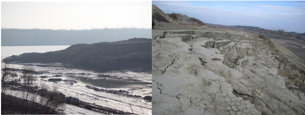
Slika 4. Poplavljeno unutrašnje odlagalište površinskog kopa Tamnava-Zapadno Polje (levo) i cirkularno klizište nakon sanacije (desno)
