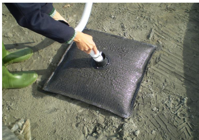
Slika 4, Punjenje geosintetičkog drenažnog kontejnera peskom iz hidrociklona na brani flotacijskog jezera Rudnik Rudnik
